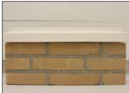
Gelakt hout op metselwerk
